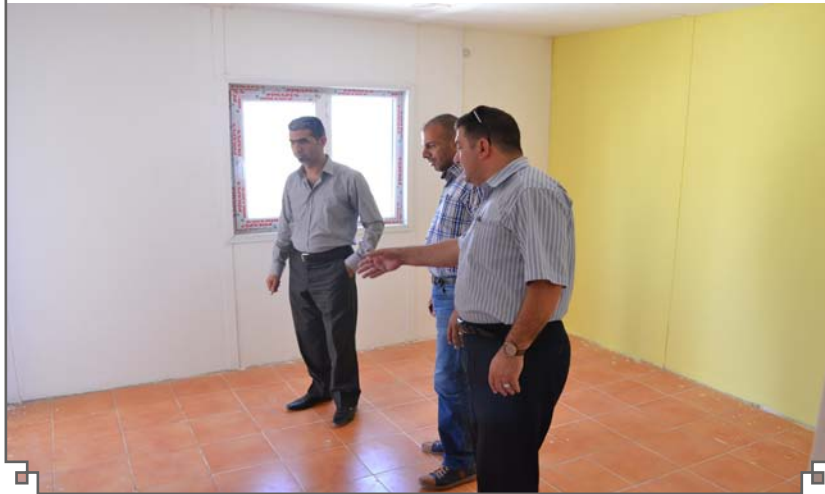
الشكل(٤):- صورة لغرفة في الوحدة السكنية تبين ارتفاع سقف الغرفة
