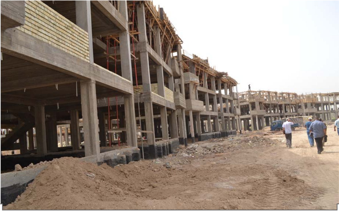
الشكل (١١): صورة عن تقدم اعمال البناء في المجمع واطيء الكلفة في بابل
